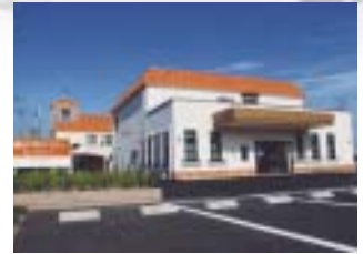
120台の駐車可能な広い敷地には、身障者用駐車スペースに屋根付き駐車場も完備しています
